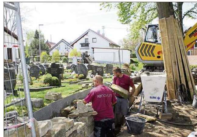
Die Bauarbeiter bauen die neue Friedhofsmauer aus den alten Sandsteinen wieder auf. Foto: Müller
