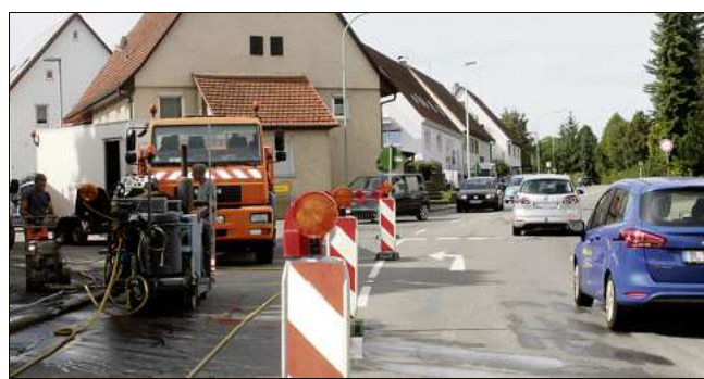
Im Zuge der Gehwegerneuerung wird die Einfahrt zur Lehrstraße verengt. Foto: Müller
