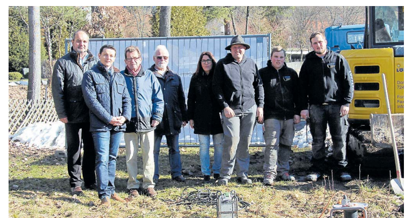
Das Fundament ist fertig: Der Schwalbenturm, der in Margrethausen aufgestellt werden soll, wird am 21. April eingeweiht. Foto: Privat
