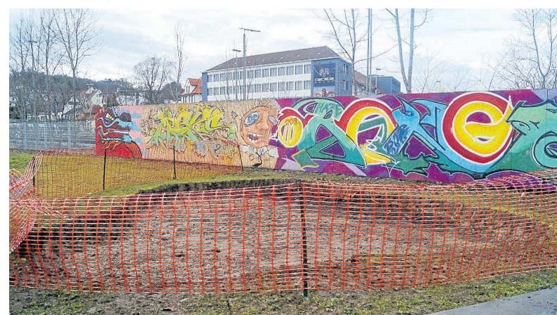
Bauarbeiter haben beim Jugendplatz am Bahnhof Löcher für die Fundamente der Sportgeräte ausgehoben. Foto: Pascal Tonnemacher
